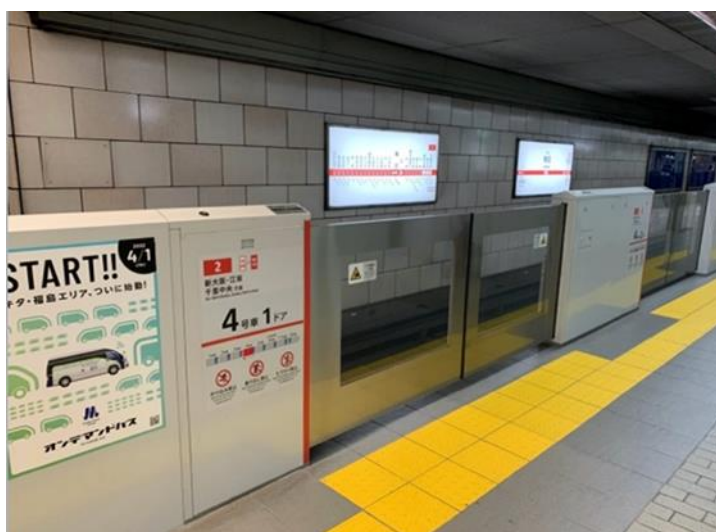
写真①:大阪市営地下鉄御堂筋線梅田駅のホームドア
